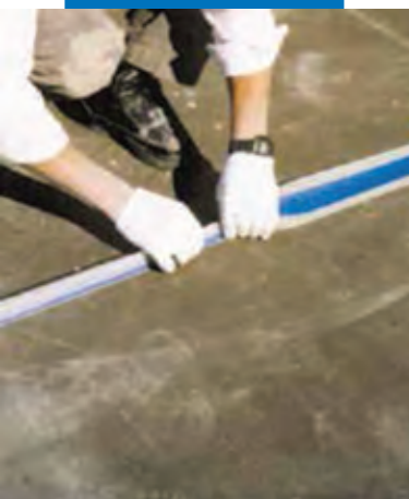
Пример гидроизоляции деформационного шва на террасе
